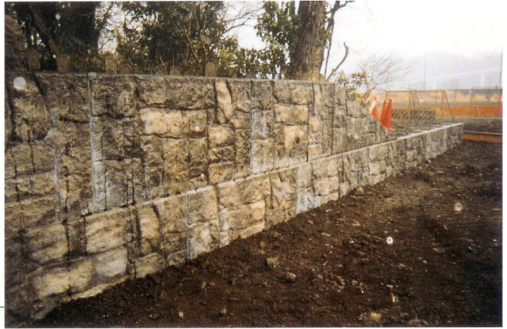
神奈川県愛甲郡愛川町 愛川畜場造成工事 発注者 愛川町役場
