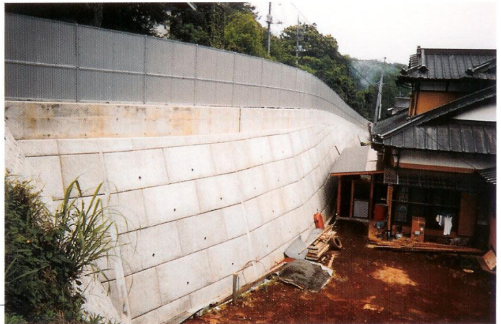
神奈川県秦野市 市道改良工事 発注者 秦野市役所
