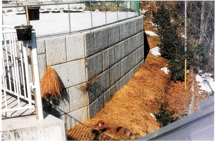
神奈川県津久井郡津久井町 町道1-1号線道路改良工事 発注者 津久井町役場
