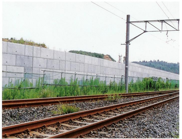
千葉県成田市久住区画駅前整備工事 発注者 久住駅前土地区画整理組合 千葉県 JR東日本
