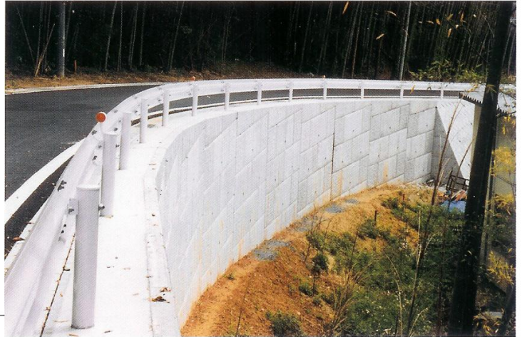
千葉県山武郡芝山町大里 道路改良工事 発注者 芝山町役場
