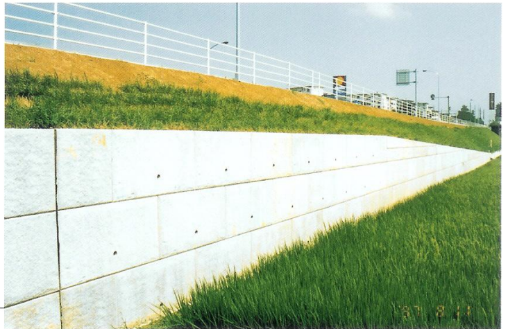
千葉県八千代市米本 道路改良工事 発注者 千葉国道工事事務所
