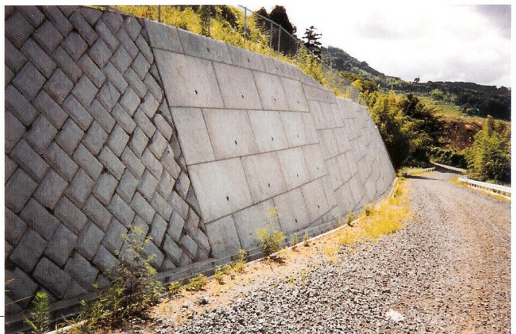
神奈川県足柄郡中井町 県広域農道整備工事 発注者 神奈川県西部農林事務所
