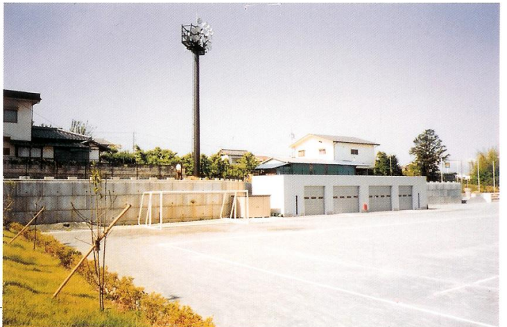
山梨県東八代郡一宮町 一宮町スポーツ広場造成工事 発注者 一宮町役場
