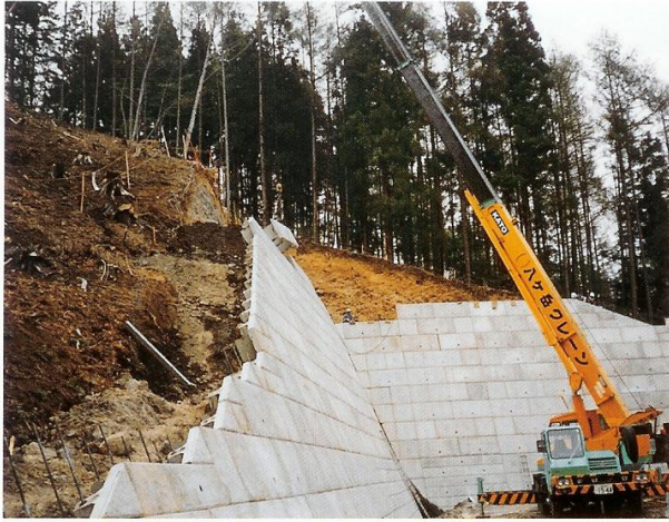
山梨県北巨摩郡高根町長沢 長沢処理区終末処理場造成工事 発注者 高根町役場
