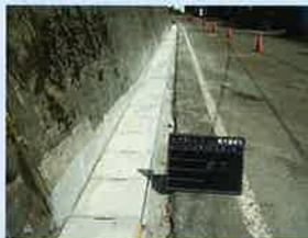
側溝の内側から切断するので、周りの地盤を荒すことがなく、接近している構造物にも影響を与えません。
