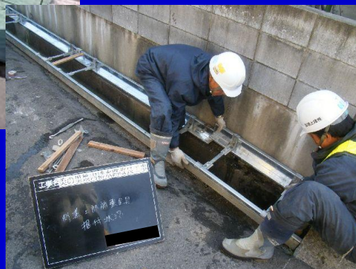
路側タイプ設置状況
