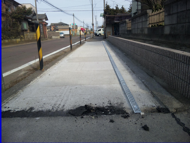
大型水路(B1400)施工状況(舗装前) (ネプラス埋設タイプ)
