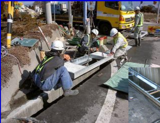
横断タイプ設置状況
