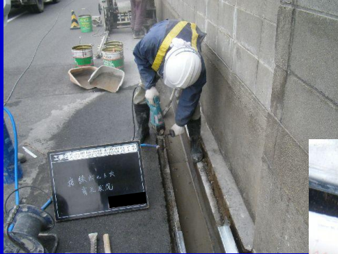
接続ボルト穴の穿孔状況
